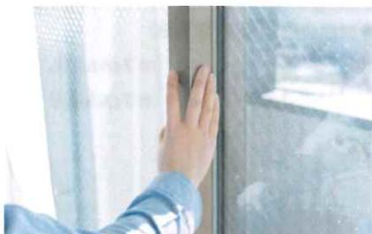
火災・震災・事故等によって破損した時にガラスが飛散しにくいことから、店舗や事務所でよく見かける、内部に金網や金属線が含まれている網入りガラスは、エッジ部の許容熱応力が普通のガラスの半分程度しかありません。これが原因となって熱割れ事故を発生させやすい網入りガラスは半面、遮熱効果を兼ね備えた製品がなく、暑さ・省エネ対策では置き去りにされてしまっています。
