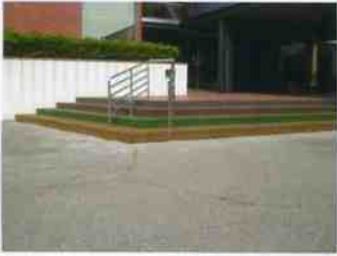
●南富良野／総合福祉センター
